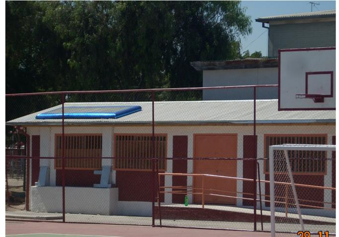
En la serie B (Serie B450-S en la fotografía) la Batería termosolar es un MURO. Los 4 modelos del bloque de concreto de la serie B, está diseñada para ir como muro. Desde un comienzo de la construcción (invisible) o como muro exterior como muestra la fotografía (bloque blanco). El colector solar se ve en azul, puede ser de varios colores o puede ir como ventana. La Batería Termosolar (El Concreto) puede ir superficial o enterrado. Ideal que se instale desde un principio de la construcción.
